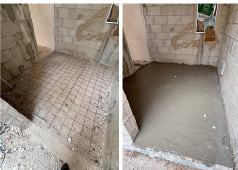
IMAGEN 6 Y 7: ANTES Y DESPUÉS DE COLADO DE FIRME EN CUARTO DE SERVICIO, EN LA IMAGEN 4 SE PUEDE OBSERVAR EL ESPACIO YA CON ACABADO.
