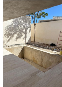
IMAGEN 3: DESPUÉS DE COLOCACIÓN DE PISOS Y RICHEADO EN ALBERCA.
