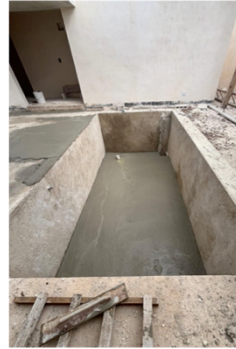
IMAGEN 2: ANTES, EN COLOCACIÓN DE PISOS Y RICHEADO
