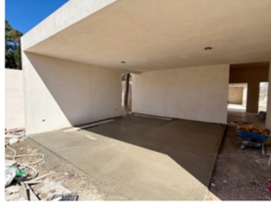
IMAGEN 1: AVANCE DE OBRA
