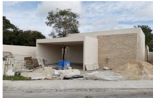
IMAGEN 8: VISTA DE FACHADA CON ACABADOS EN MUROS Y FIRME EN COCHERA
